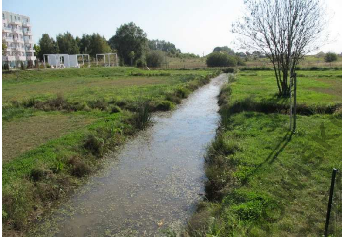
Fot. 5. Fragment otwartego rowu na terenie osiedla mieszkaniowego 18'36, stanowiący górny odcinek potoku M2, teren przeznaczony pod planowany zbiornik retencyjny i potok M2, z dopuszczeniem miejskiej zieleni urządzonej ogólnodostępnej (teren 25-D).
