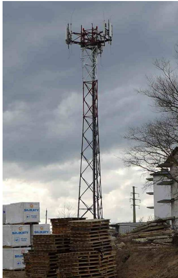
Fot. 7. Wieża telefonii komórkowej przy ulicy Borkowskiej
