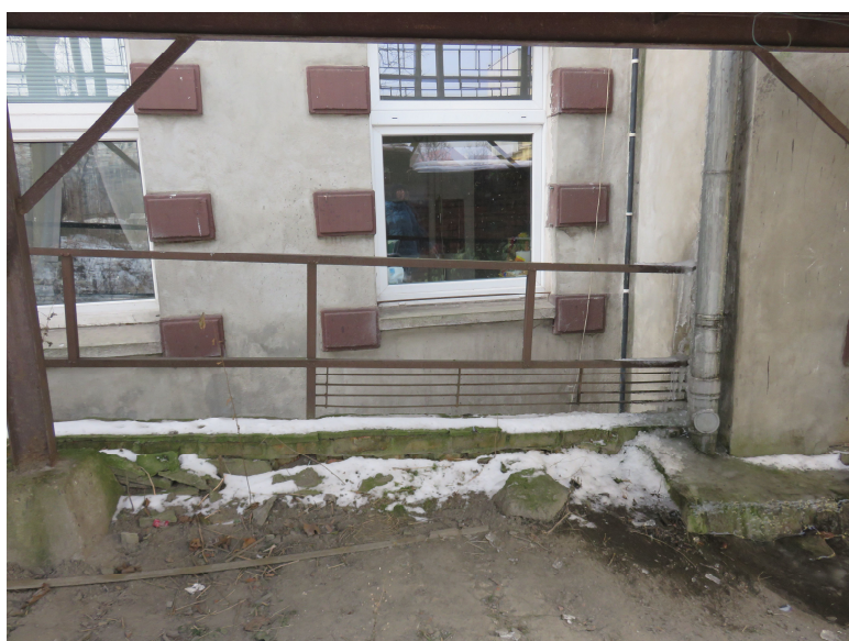
Widoczny murek i stojąca na nim balustrada – w złym stanie technicznym
