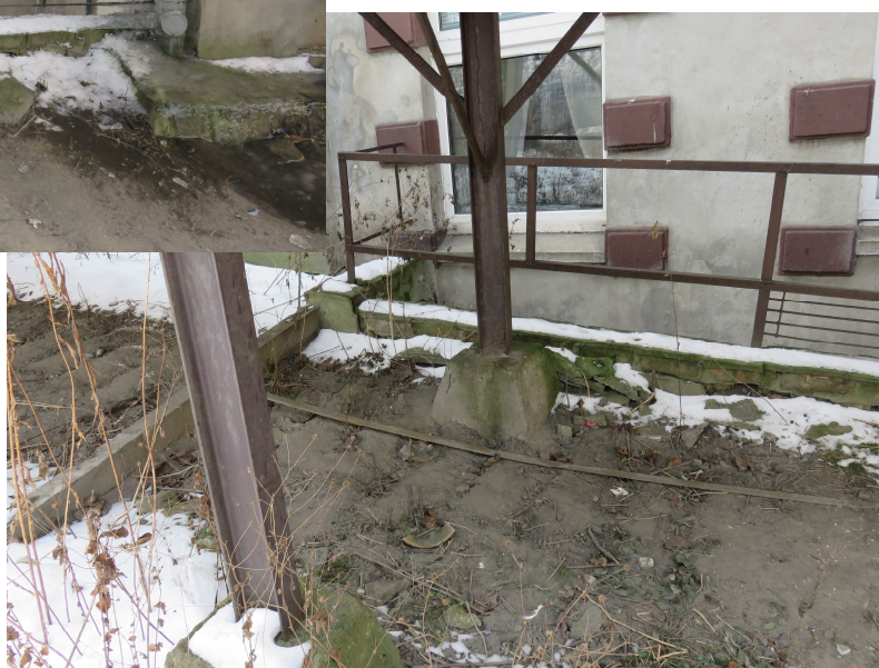
Widoczny murek i stojąca na nim balustrada – w złym stanie technicznym
