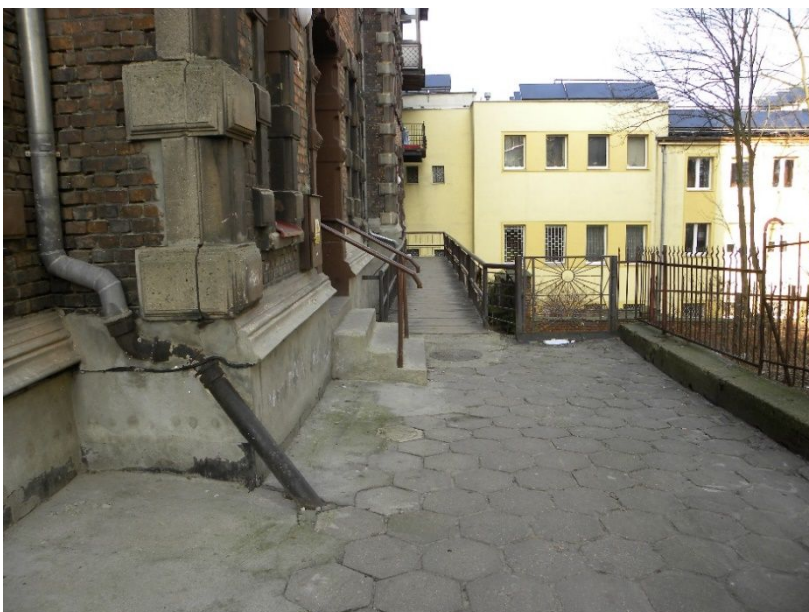
widoczna rura spustowa „wkomponowana” we fragment muru cokołu
