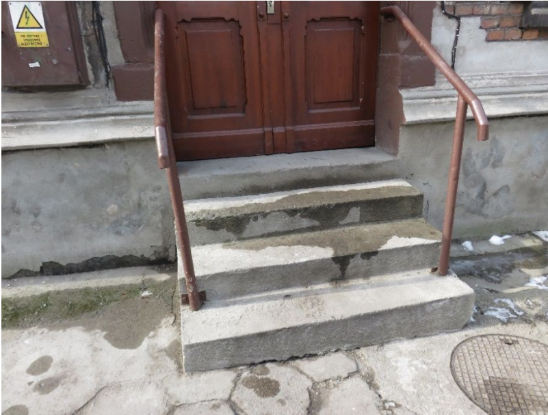
widoczne wejście do klatki pd. i balustrada
