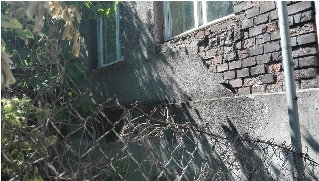
Widoczny fragment cokołu i ściany najniższej kondygnacji
