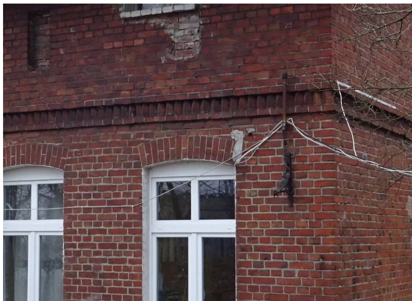
5. Widok starych elementów instalacji elektrycznej – do likwidacji, wkucia
