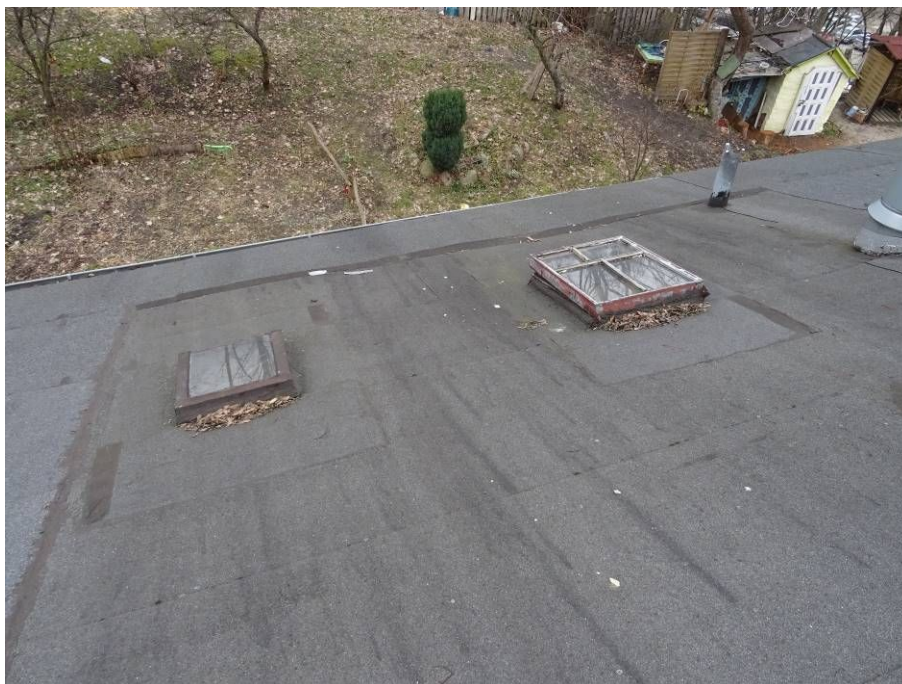
9. Widok stanu pokrycia dachu
