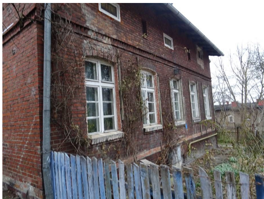
2. Widok elewacji tylnej przeznaczony do renowacji
