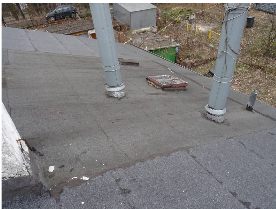
8. Widok stanu pokrycia dachu
