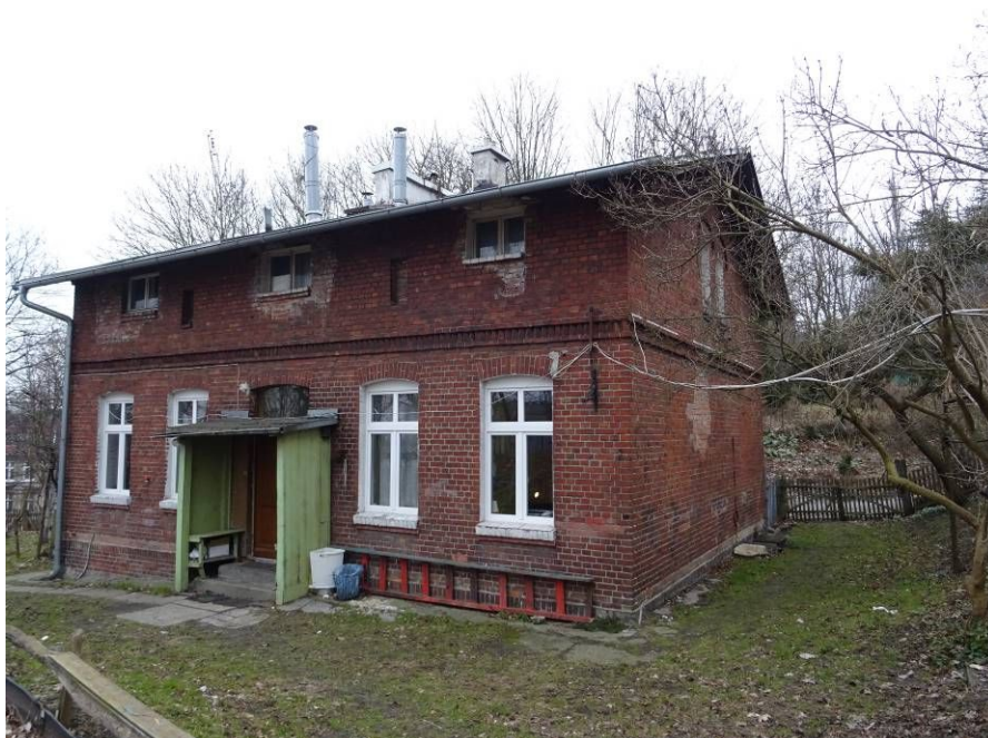
1. Widok elewacji frontowej przeznaczony do renowacji
