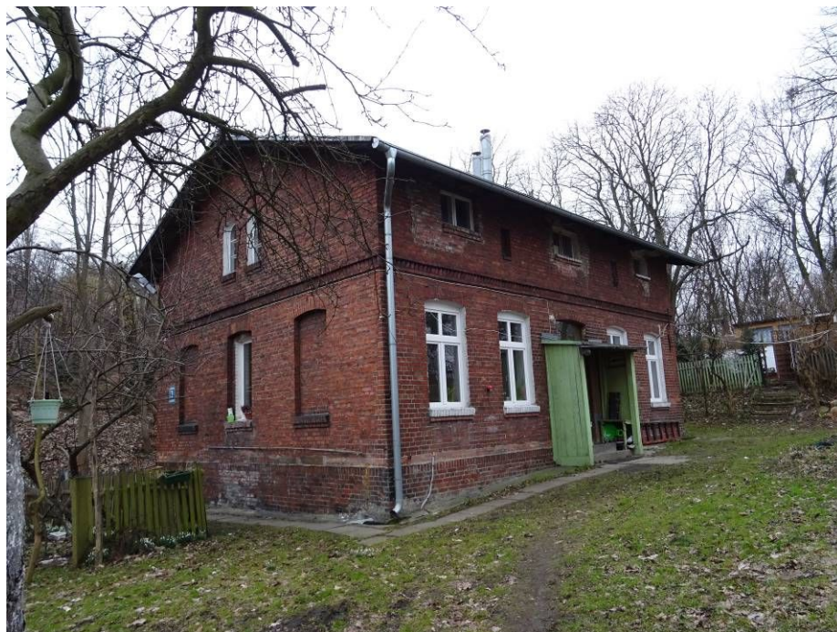
3. Widok elewacji szczytowej przeznaczonej do renowacji
