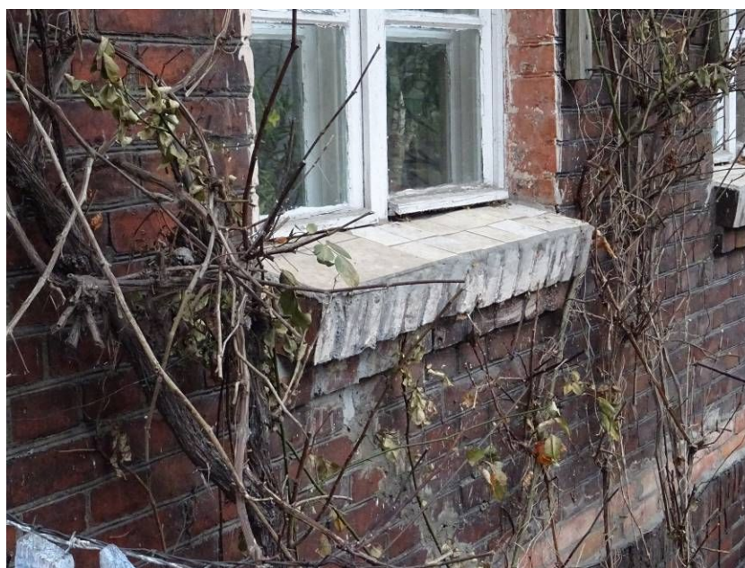
9. Widok parapetów ceglanych do renowacji
