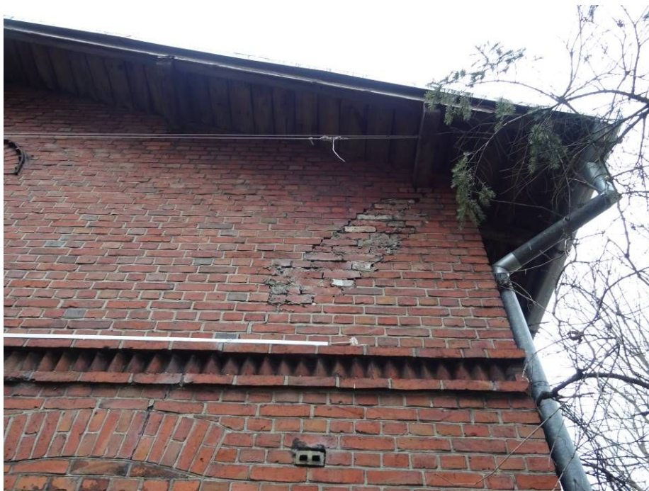
10. Widok ściany przeznaczonej do renowacji
