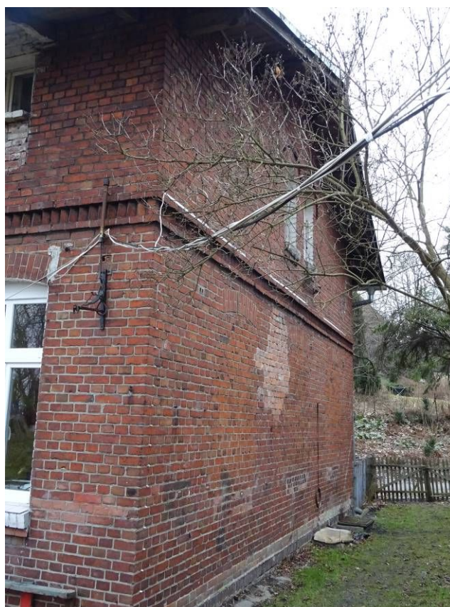
4. Widok ściany szczytowej przeznaczonej do renowacji
