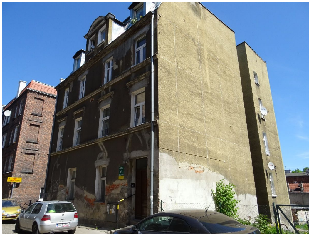
3. Widok elewacji bocznej (zachodniej)
