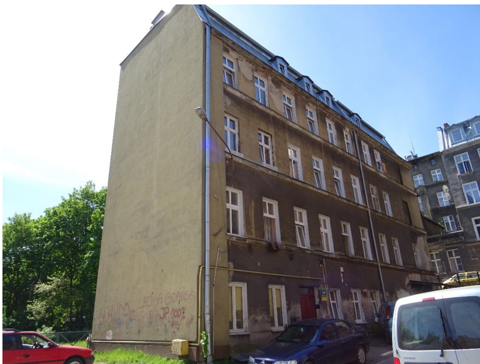
1. Elewacja Frontowa (Północna)
