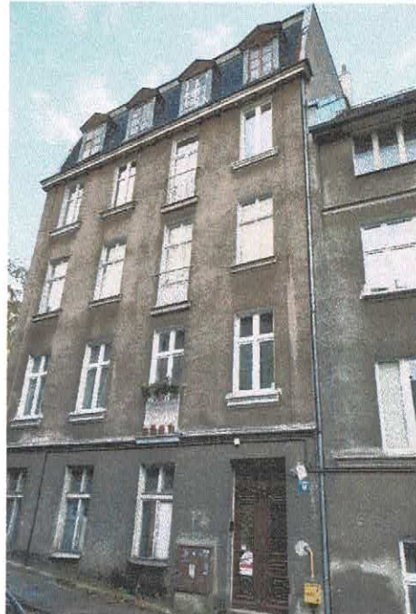
Elewacja wschodnia, dach istniejący.
