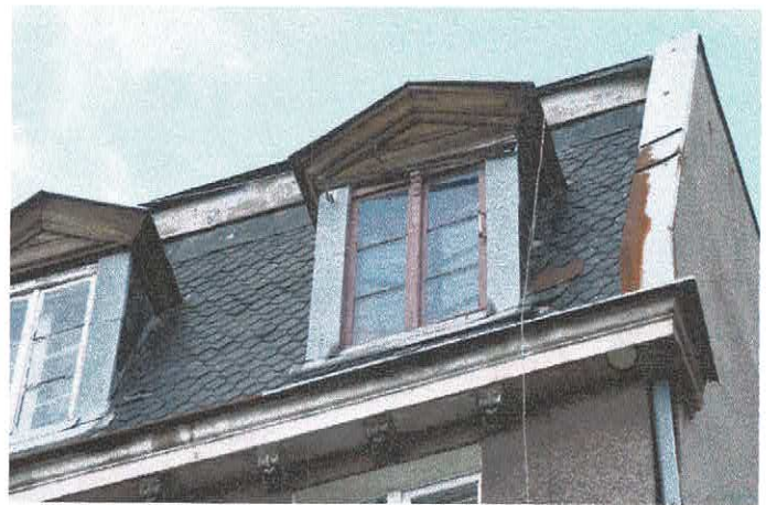
Elewacja wschodnia, dach istniejący.
