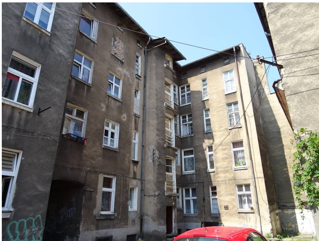
2. Elewacja tylna (wschodnia)
