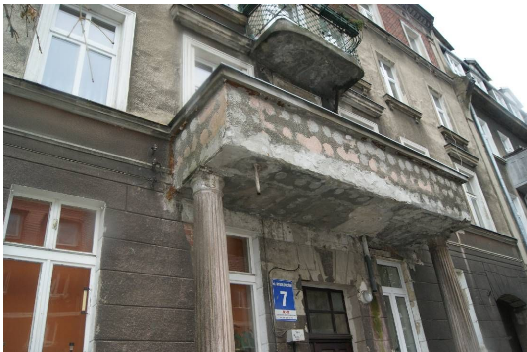
3. Widok balkonów do remontu
