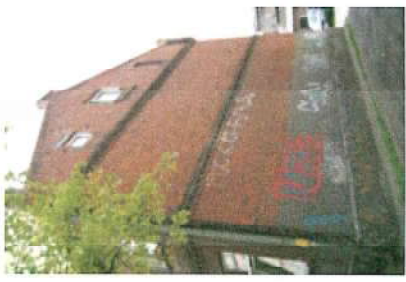
widok elewacji szczytowej
