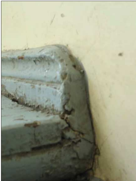
Widok istniejącej listwy na podeście między IV a V piętrem.
