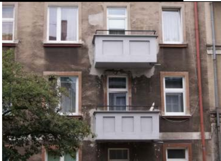
FOT. 6 – BALKONY NA ELEWACJI FRONTOWEJ
