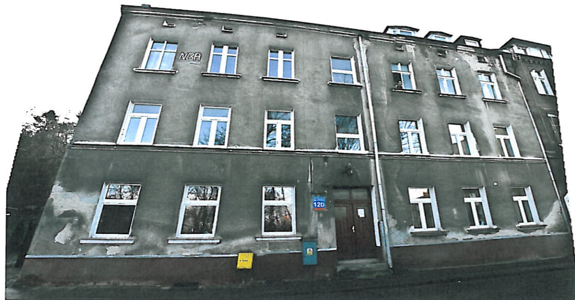
Zdjęcie nr 1. Elewacja wschodnia ( frontowa) budynku mieszkalnego przy ul.Na Stoku 12D.
