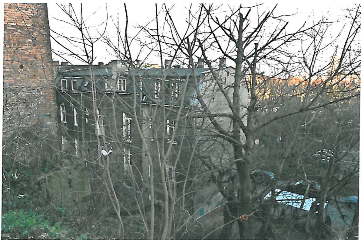
Zdjęcie nr 2. Elewacja zachodnia ( od strony stoku) budynku mieszkalnego przy ul.Na Stoku 12D.
