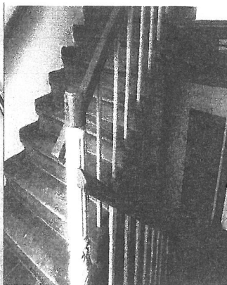
fot. 3 klatka schodowa nr9
