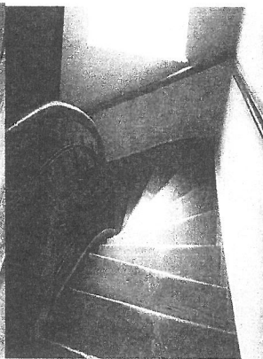
fot. 2 klatka schodowa nr8a
