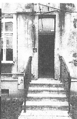
fot. 4 klatka schodowa nr9a (wejście od strony podwórka)
