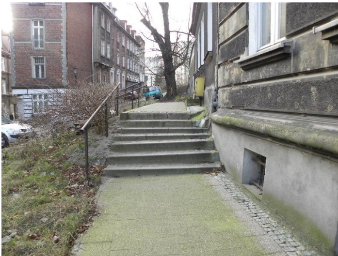
Widoczna opaska przy budynku nr 2 oraz schody na pograniczu budynków
