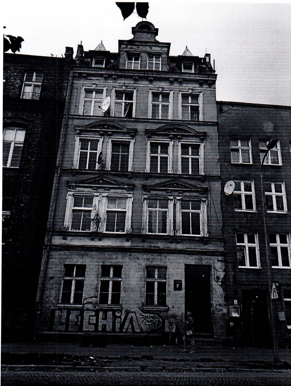
Zdjęcie nr 1. Elewacja południowo - wschodnia budynku mieszkalnego przy ul Dolna Brama 7w Gdańsku.
