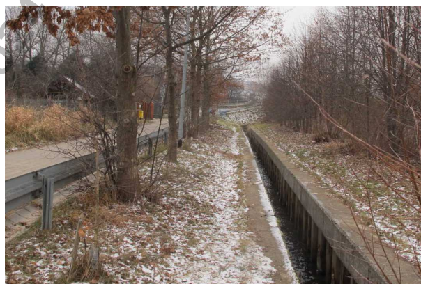
Fot. 3. Potok Oruński w rejonie ulicy Bieszczadzkiej, teren 14.2 KDD.
