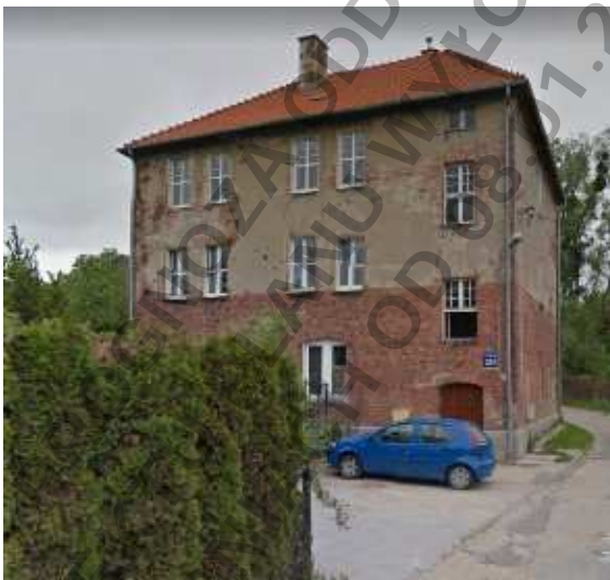
Fot. 23. Budynek mieszkalny wielorodzinny, zlokalizowany ulicy Kartuskiej nr 251 (teren 03-M/U31), ujęty w gminnej ewidencji zabytków.
