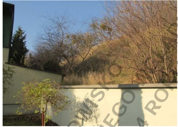
Fot. 16. Ściana oporowa na północ od budynku lecznicy dla zwierząt – teren 01-M/U31.
