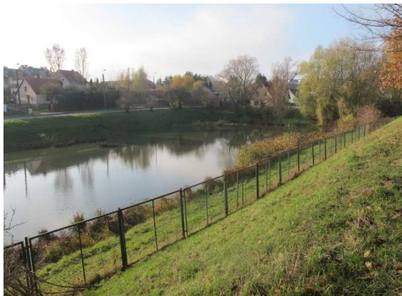
Rys. 13. Skarpa schodząca do ogrodzenia zbiornika retencyjnego Zabornia - znajdująca się bezpośrednio na zachód od terenu 03-M/U31.
