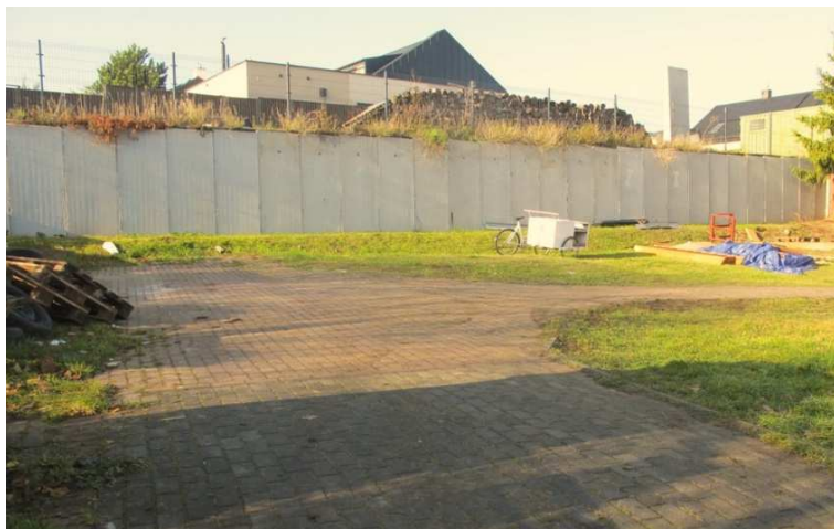
Fot. 9. Ściana oporowa na terenach między ulicami Miłosa i Lema (teren 04-MN21).
