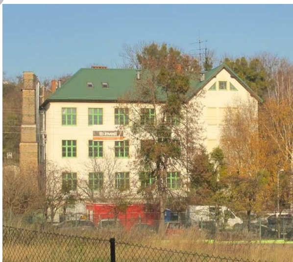
Fot. 24. Budynek, w którym mieści się Zakład Higieny Weterynaryjnej, zlokalizowany przy ulicy Kartuskiej nr 249 (teren 01-M/U31), ujęty w gminnej ewidencji.
