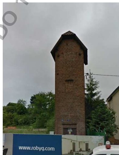
Fot. 18. Wieża trafostacji zlokalizowana przy ulicy Kartuskiej – teren 03-M/U31.
