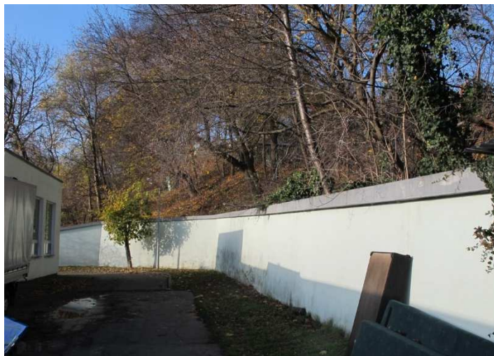
Fot. 11. Ściana oporowa podpierająca podcięte, północne zbocze doliny Potoku Siedleckiego w rejonie lecznicy dla zwierząt (teren 01-M/U31).
